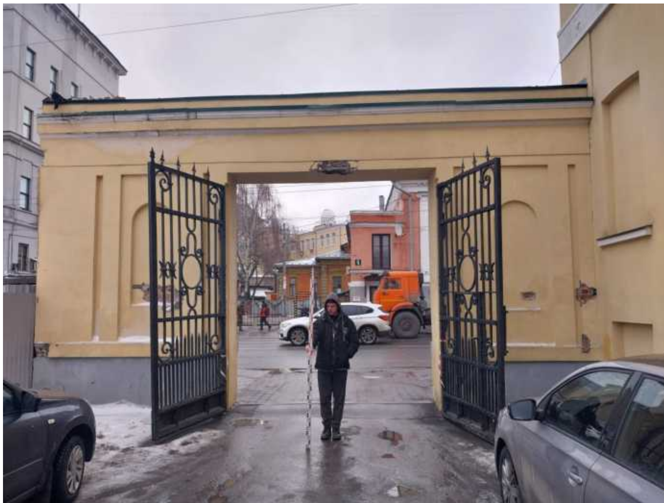
Илл. 21. Нижегородская область, г. Нижний Новгород, ул. Варварская, д. 3, работы по сохранению объекта культурного наследия федерального значения «Дом, в котором в разные годы бывали революционеры Лопатин Герман Алексеевич, просветитель Ульянов Илья Николаевич, композитор Балакирев Милий Алексеевич», приспособление к современному использованию въездных ворот, примыкающих к северной части фасада - 2025 г.
